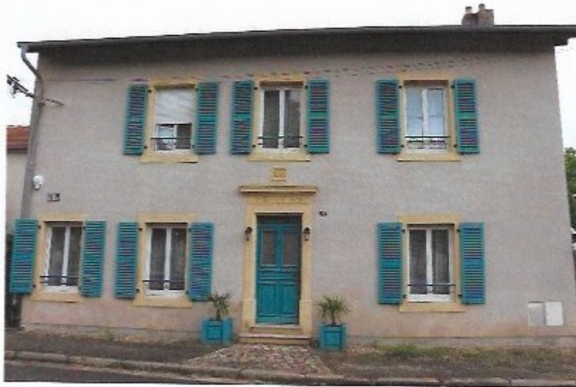
Maison lorraine ayant conservée, à l'exception de ses menuiseries, ses caractéristiques d'origine. 4 rue du Moulin
