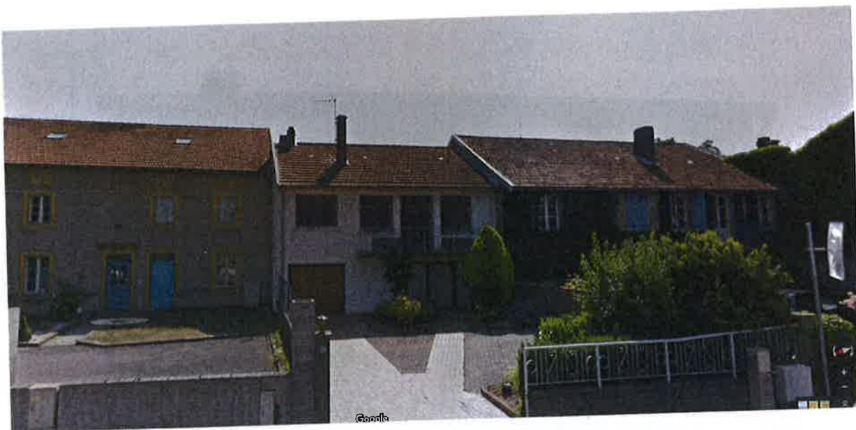
Usoirs minéralisés avec espaces résiduels végétalisés, rue de Metz
