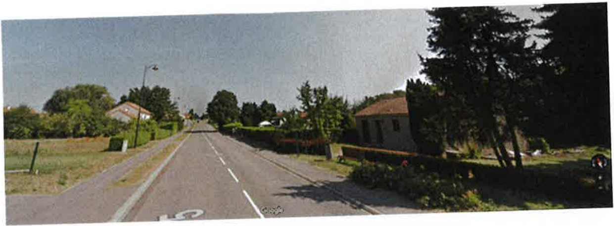
Entrées sud rue de Metz (D5)
